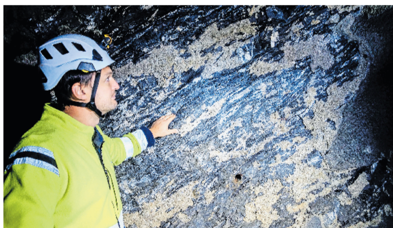
Oben: Die punktuelle Sanierung des EKW-Fensterstollens in der Val Sampuoir bedingt viel mühsame Handarbeit. Mitte: Salvatore Mammoliti beim Eingang und bei den Arbeitern im Stollen. Unten: Michael Spechtenhauser bei einer geologischen Störzone. Rechts die Wasserfassung in der Val Sampuoir. Fotos: Jon Duschletta
